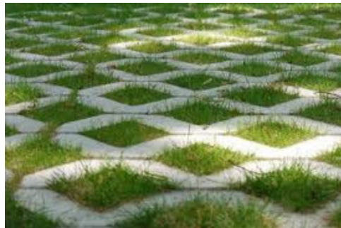
Versickerung auf der Fläche durch teilbewachsene Systeme wie Rasengittersteine, Rasenfugenpflaster
