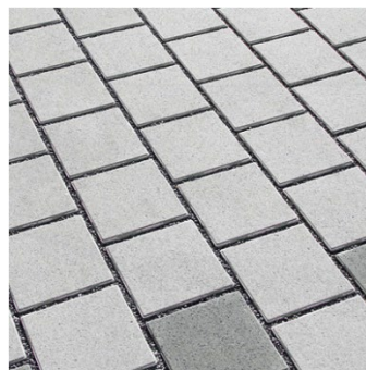
Versickerung auf der Fläche ohne belebte Bodenschicht wie Verbund- und Sickersteine.
