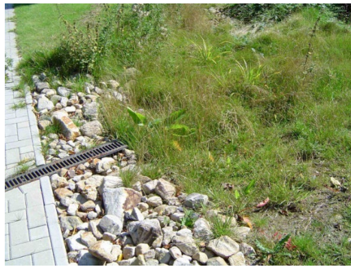
Oberflächliche Entwässerung über die Schulter und Versickerung in der angrenzenden Grünfläche.
